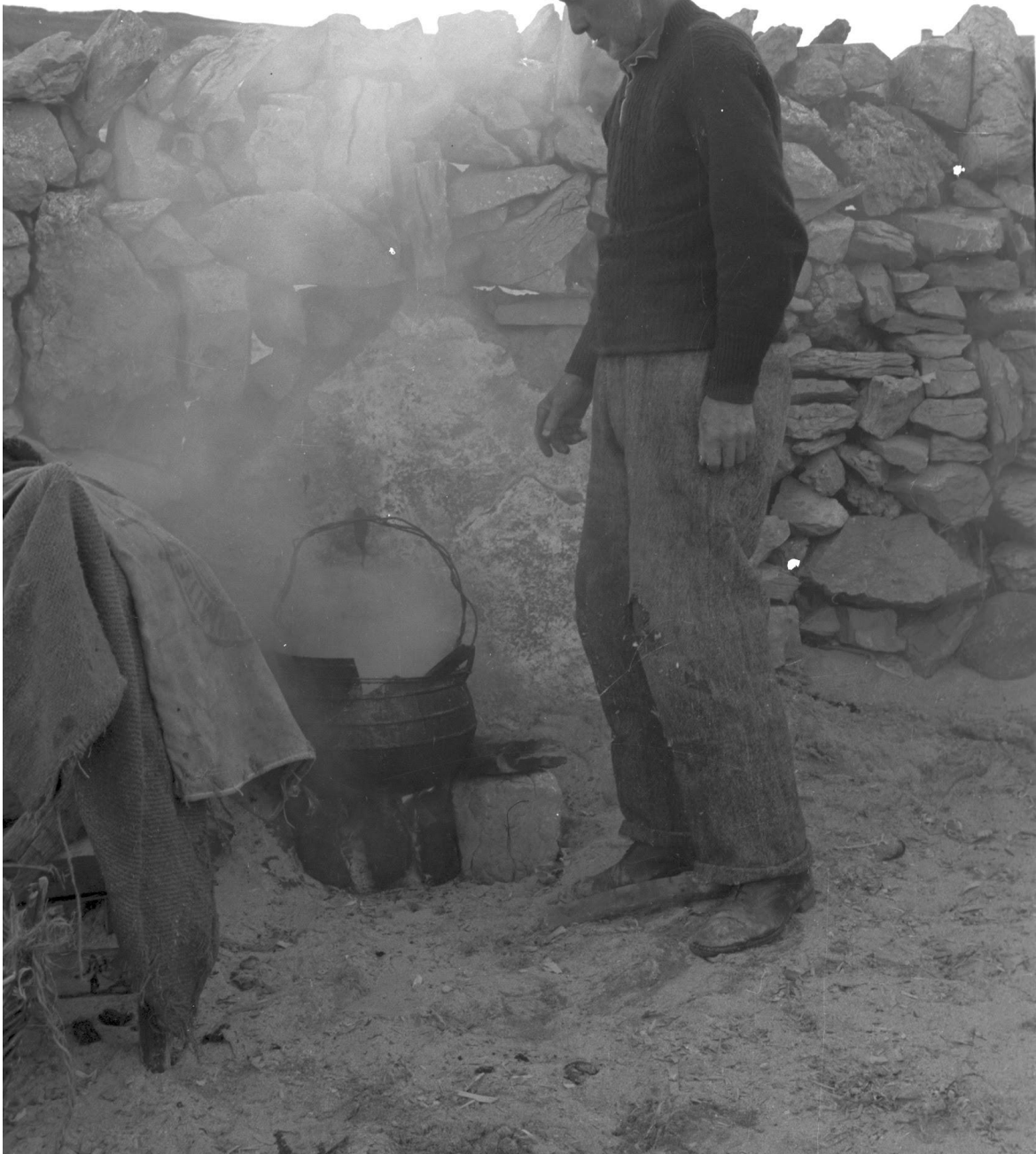
An siúinéir Séan Ó Conaola ag téamh tarra le cur ar chraiceann curaigh, Inis Oírr, Co. na Gaillimhe (gan dáta) C021.01.00086
